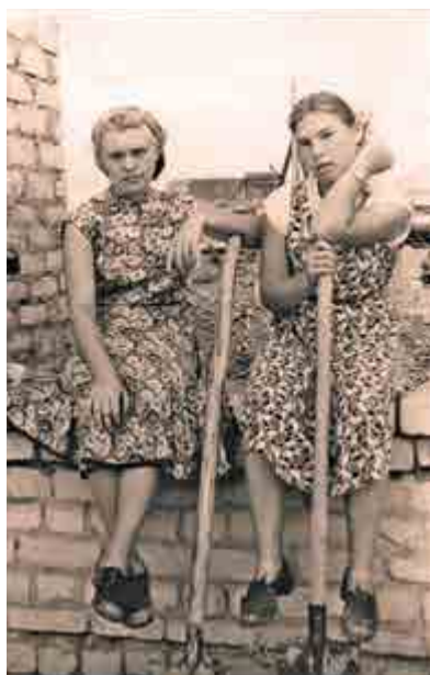
На строительстве заводских корпусов.
