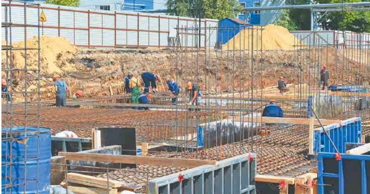
Монтаж армирующего каркаса ростверка фундамента.
