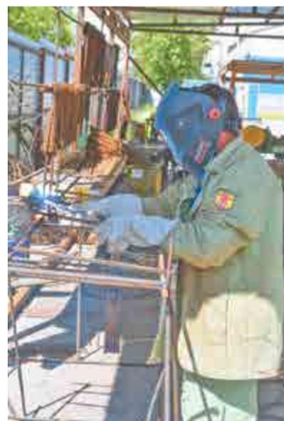
Сварка поддерживающего арматурного каркаса.
